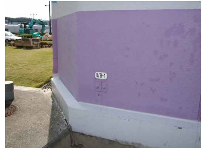
3号機原子炉建屋の測定点
