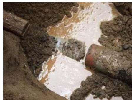
配管の破損状況
