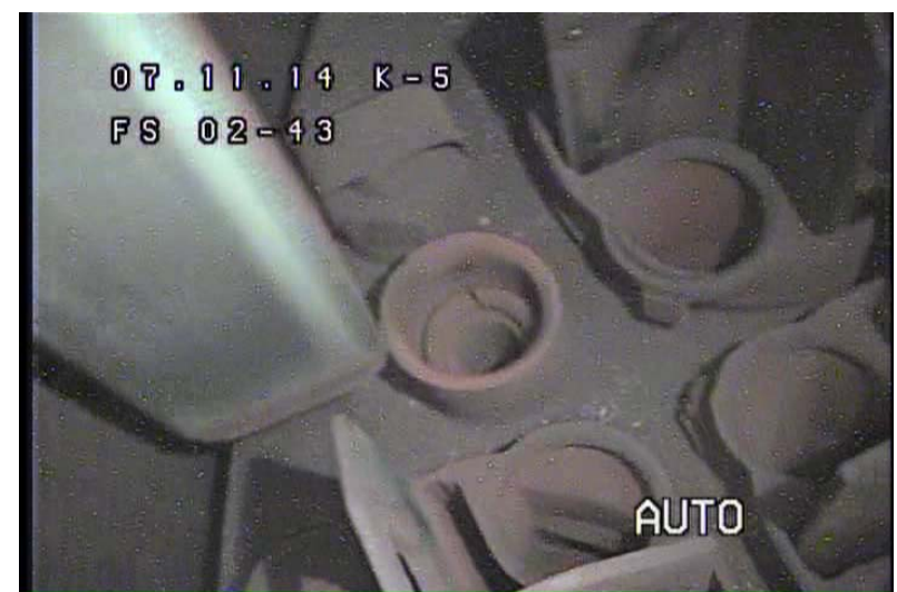
燃料集合体が燃料支持金具の外側へずれた状態
