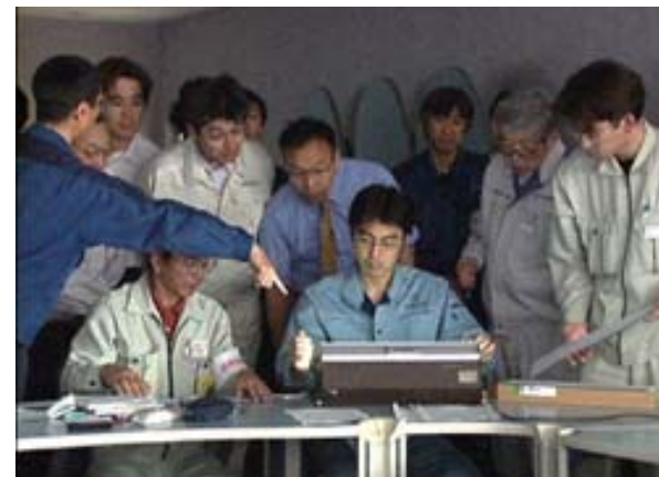
自治体による状況確認 (非破壊検査)
