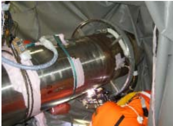
内面水冷却による溶接作業
