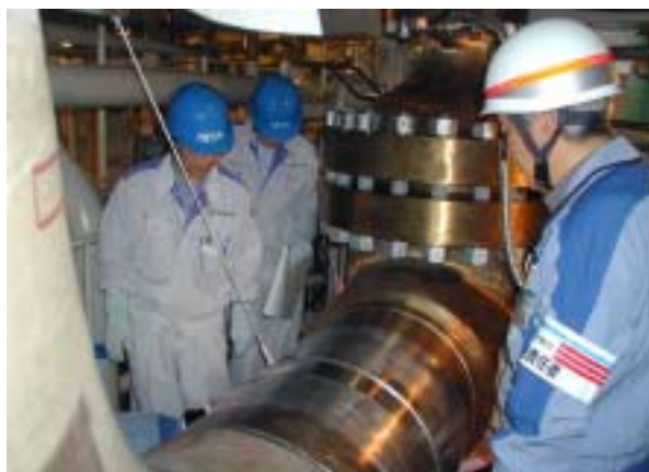
保安検査官による 水圧試験の立ち会い
