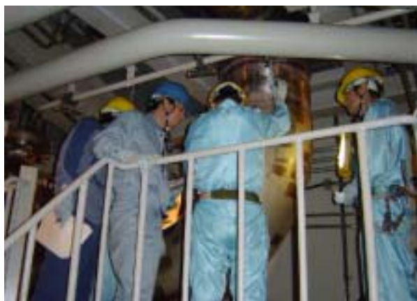
発電設備技術検査協会 による超音波検査
