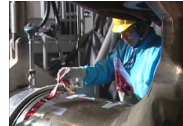
液体浸透探傷検査
