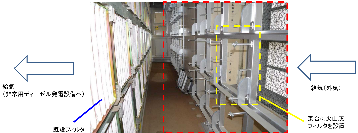
火山灰フィルタ設置架台
