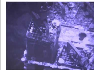
燃料取り出しの状況 (撮影日2019年4月15日)
