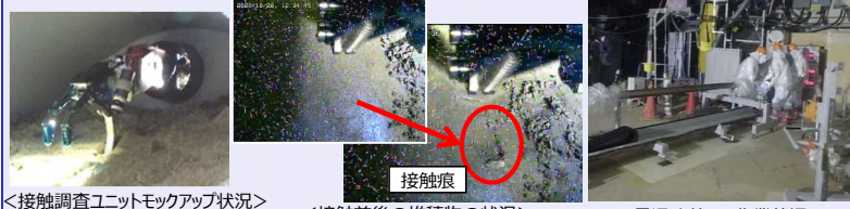
<接触調査ユニットモックアップ状況>
