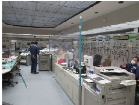
中央制御室での仕切り設置
