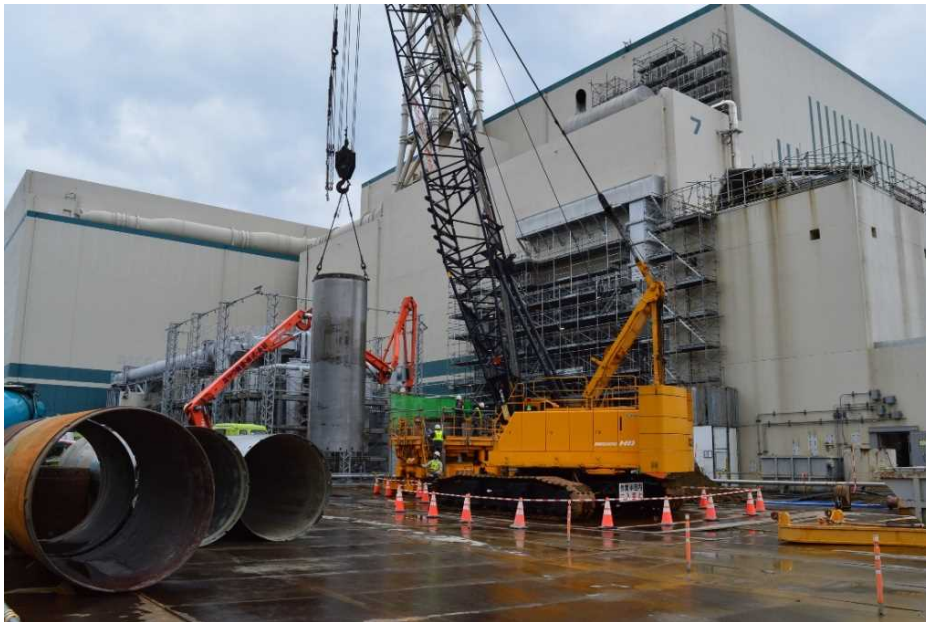
7号機フィルタベント設備付近液状化対策工事 (撮影日：2020年2月)
