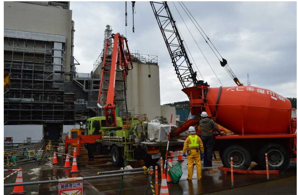
7号機フィルタベント設備付近液状化対策工事 (撮影日：2020年2月)
