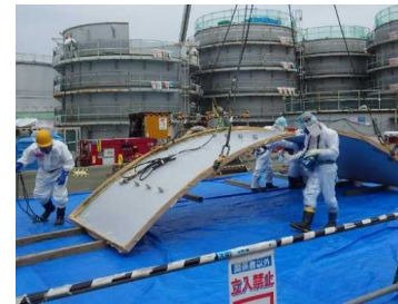
フランジタンク解体のカイゼン（福島第一）
