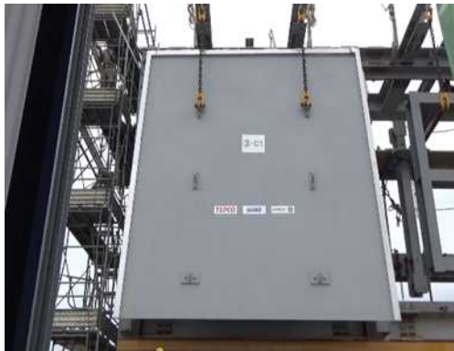
オペロBOP開放試験状況
