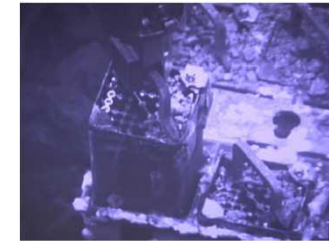
燃料取り出しの状況 (撮影日2019年4月15日)
