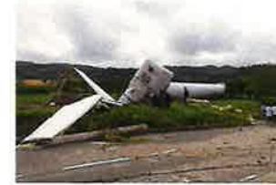
兵庫県淡路市風力発電設備倒壊 (2018年8月台風)
