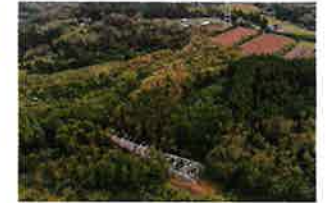
千葉県君津市送電線鉄塔倒壊 (2019年9月台風)
