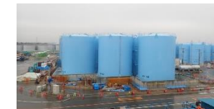
(溶接型タンク設置状況)
