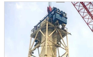
【写真①】筒身切断状況(10月27日)
