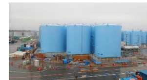
(溶接型タンク設置状況)
