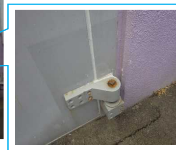
扉と枠の隙間をコーキング処理
