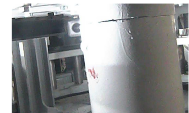
【写真④】主柱材切断状況(11月26日)
