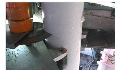
【写真③】斜材切断状況(11月7日)
