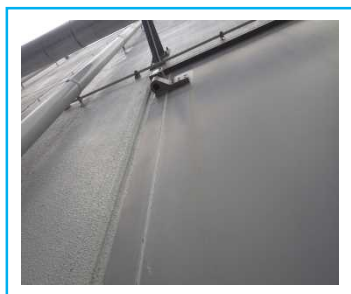
扉と枠の隙間をコーキング処理
