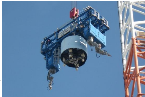
排気筒吊下ろし作業
