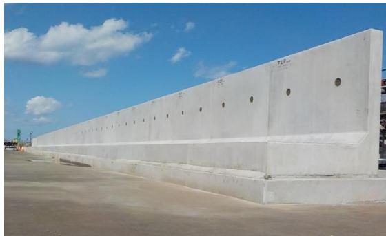
防潮堤設置状況
