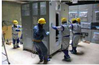
1号機 電源盤(P/C 1C-1)据付作業
