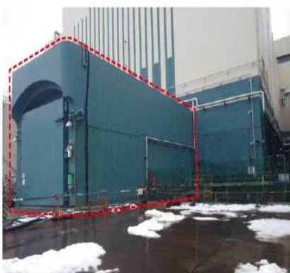
7号機原子炉建屋大物搬入口
