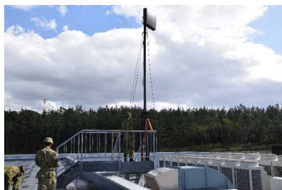
屋外アンテナの設置
