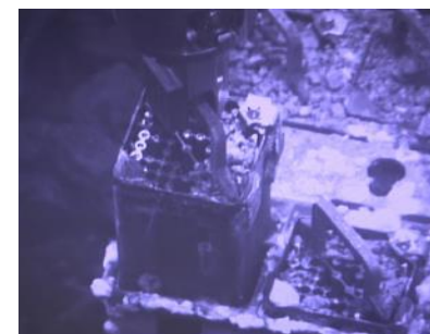
燃料取り出しの状況 (撮影日2019年4月15日)
