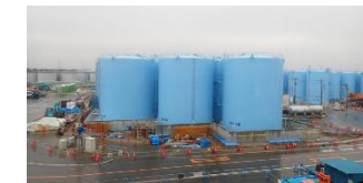
(溶接型タンク設置状況)
