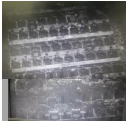
ガレキ撤去後の使用済燃料プール
