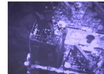
燃料取り出しの状況 (撮影日2019年4月15日)
