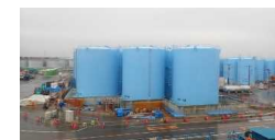
(溶接型タンク設置状況)
