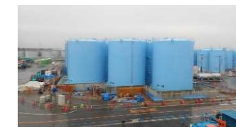
(溶接型タンク設置状況)
