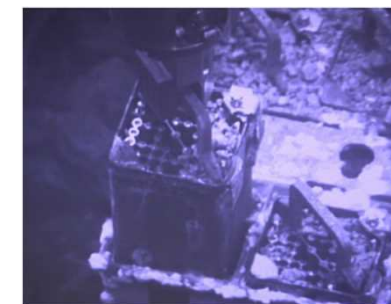
燃料取り出しの状況 (撮影日2019年4月15日)
