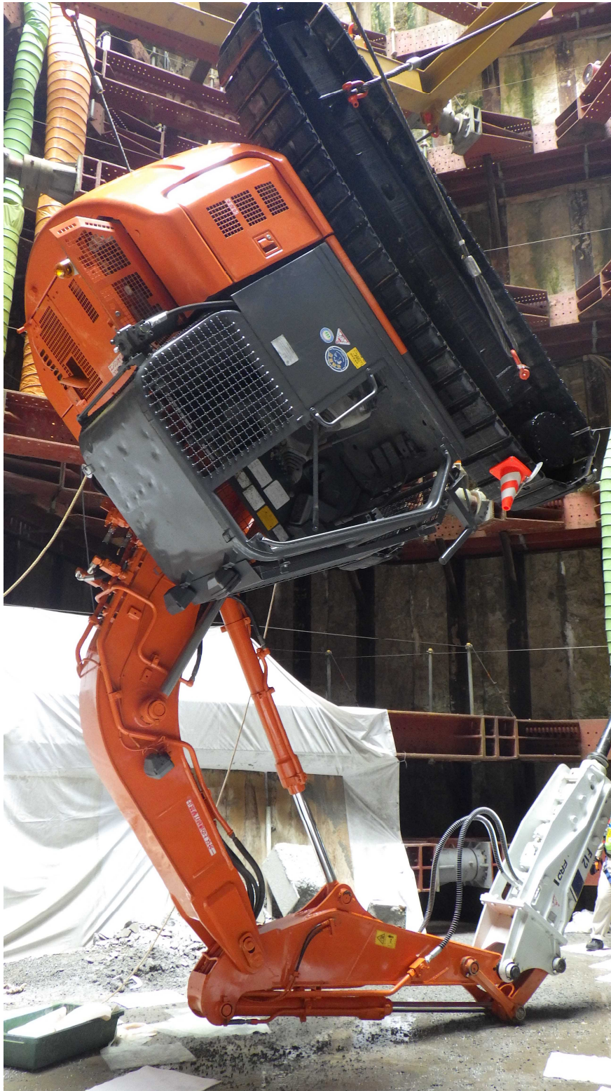
重機を下ろした状態
