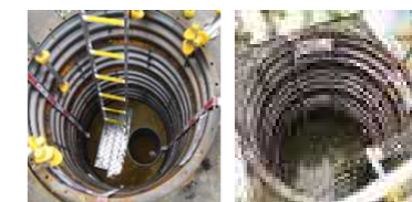
陸側遮水壁 内側 陸側遮水壁 外側
