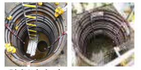
陸側遮水壁 内側 陸側遮水壁 外側
