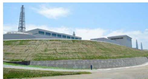
【防潮堤（5～7号機側）】
