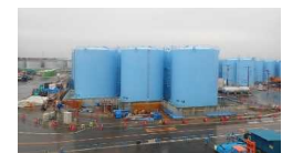
(溶接型タンク設置状況)
