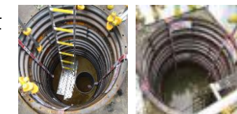
陸側遮水壁 内側 陸側遮水壁 外側
