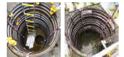
陸側遮水壁 内側 陸側遮水壁 外側
