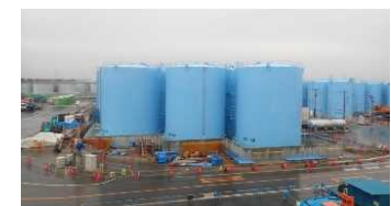
(溶接型タンク設置状況)
