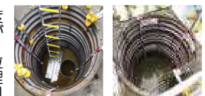
(陸側遮水壁) (陸側遮水壁) 内側 外側
