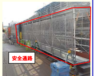
屋根付き安全通路の設置状況
