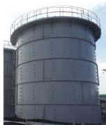
ALPS処理水タンク (フランジ型タンク) 水抜き・解体 (G4北、G5エリア)
