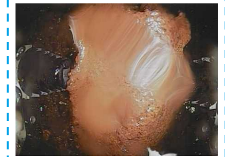
底部-6の調査状況
