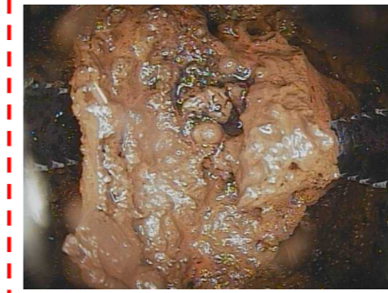
底部-5の調査状況
