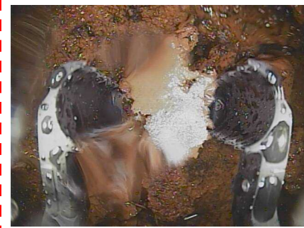
底部-1の調査状況
