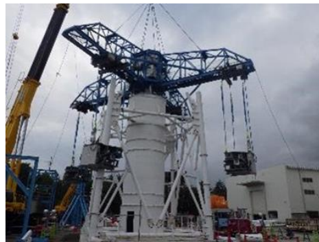
模擬排気筒を使用した検証作業
