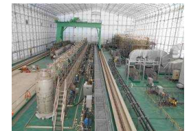
(高性能多核種除去設備)
