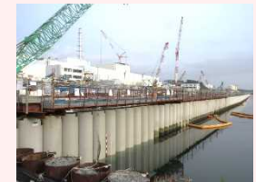
海側遮水壁 鋼管矢板打設完了状況
