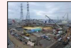
H1東エリア解体後の様子
