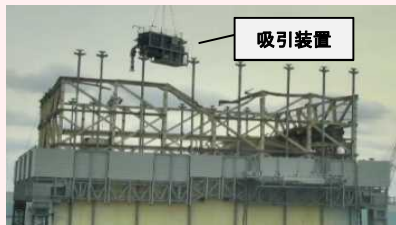
<進捗状況(1/22撮影)>
