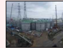
H1東エリア解体開始時の様子
