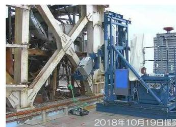
※ 防風フェンスは、ダスト飛散リスクのさらなる低減を目的に設置しています。
