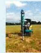
設備設置に向けた 調査・実証研究
