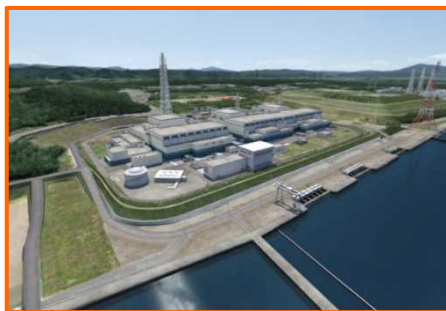
【柏崎刈羽原子力発電所】
