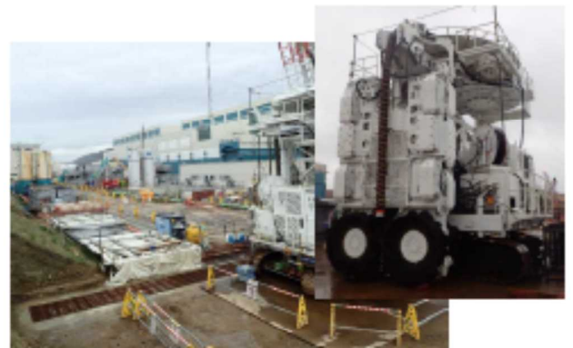
【6号機タービン建屋付近】
