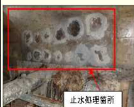
止水処理前 2号機取水電源ケーブル貫通部の止水状況
