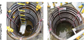
(陸側遮水壁) 内側 (陸側遮水壁) 外側
