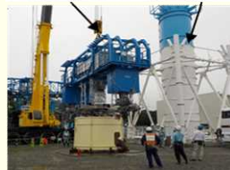
モックアップ試験の状況
