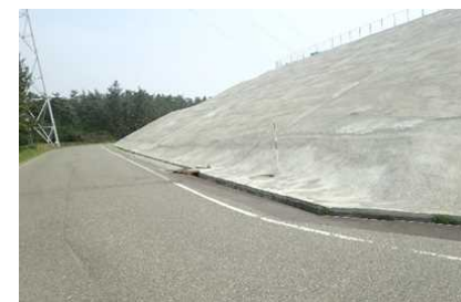
防火帯（整備完了後）
