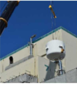
取付工事の様子
