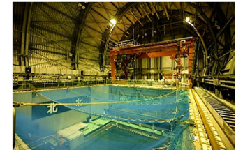
燃料取り出し用カバー内部の状況 (撮影日2018年3月15日)
