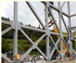
モックアップ試験の状況
