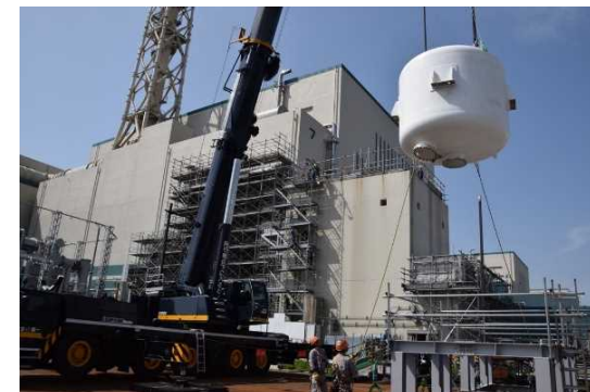
7号機よう素フィルタの搬出作業風景
