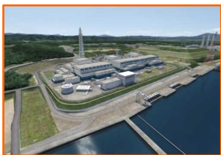
【柏崎刈羽原子力発電所】
