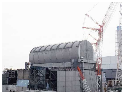
3号機 燃料取り出し用ドーム屋根設置完了 (2月23日)
