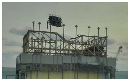
1号機 原子炉建屋最上階のガレキ撤去開始 (1月22日)
