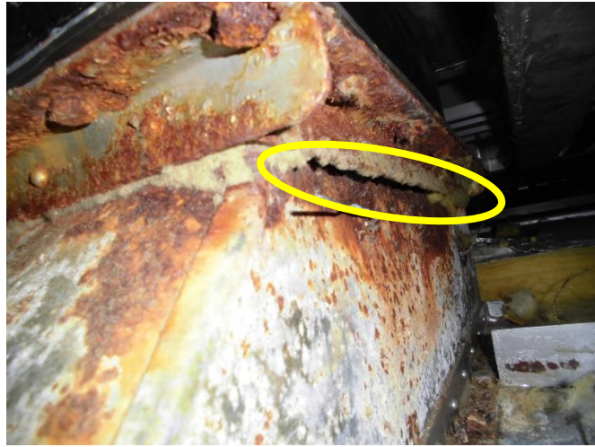
拡大写真（隙間 約1 cm×50cm）
