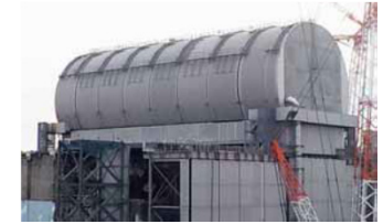
ドーム屋根設置状況 (撮影日2018年2月21日)
