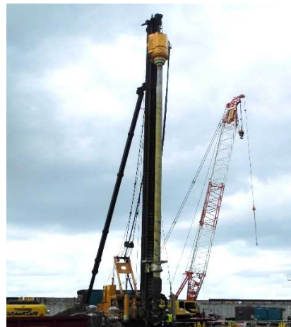
例 1) 機械攪拌工法
