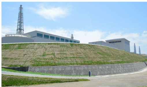
【防潮堤（5～7号機側）】
