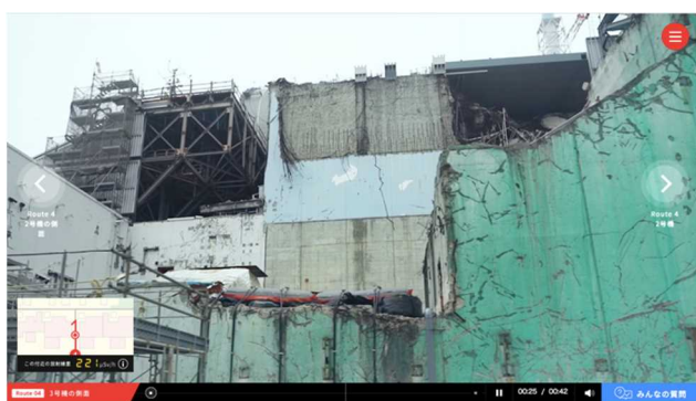
水素爆発した3号機原子炉建屋
