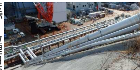
ブライン配管の設置状況
