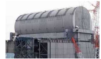
ドーム屋根設置状況 (撮影日2018年2月21日)
