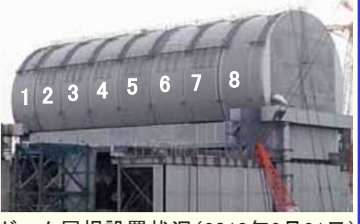
ドーム屋根設置状況(2018年2月21日)
