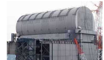
ドーム屋根設置状況 (撮影日2018年2月21日)
