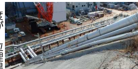
ライン配管の設置状況
