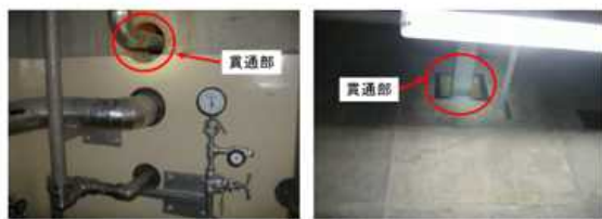
1/2号機サービス建屋 地下1階(放射性廃棄物処理系サブポンプ室入口付近) 4号機原子炉建屋 地下5階(通路)
