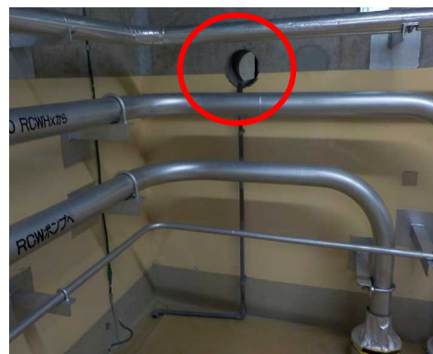
2号機原子炉建屋（管理区域） 地下1階
