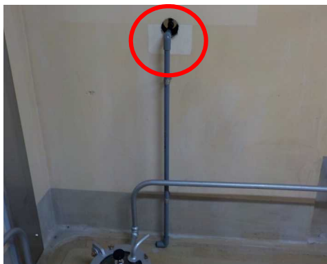
2号機原子炉建屋（管理区域） 地下5階
