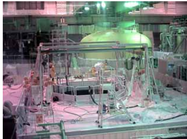
シュラウドの点検・補修の様子
