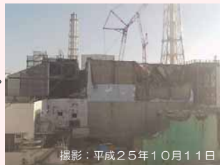
撮影:平成25年10月11日 大型ガレキ撤去後
