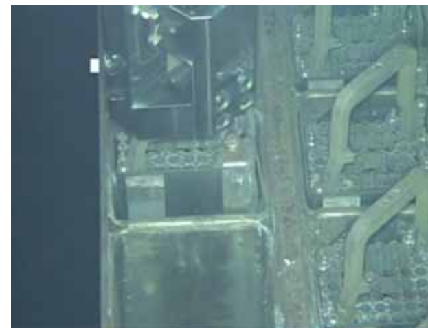
燃料取り出し作業（11/18）
