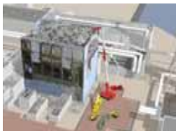
原子炉建屋上部のガレキ撤去
