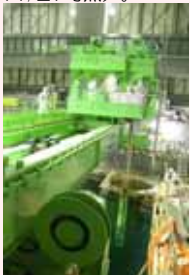
燃料取り出し状況
