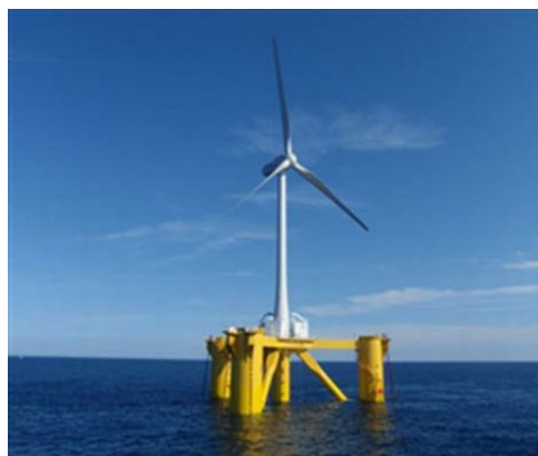
2MW 浮体式洋上風力発電設備
