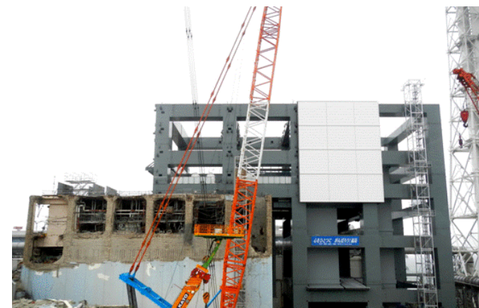
鉄骨建方完了(5/29撮影)
