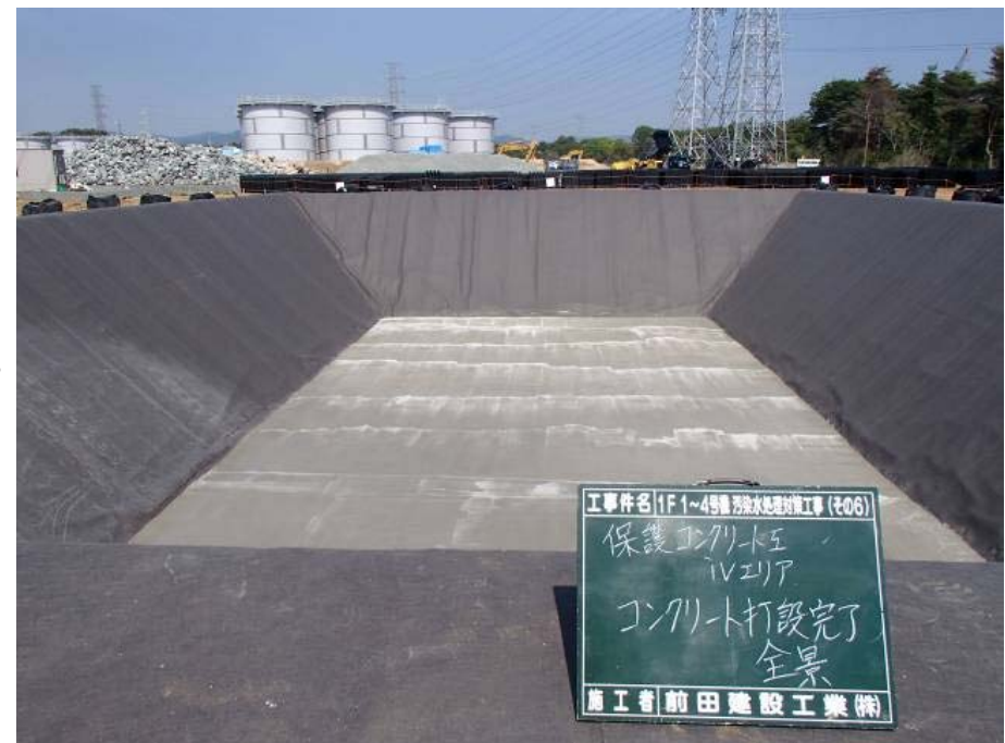
【保護コンクリート打設完了】
