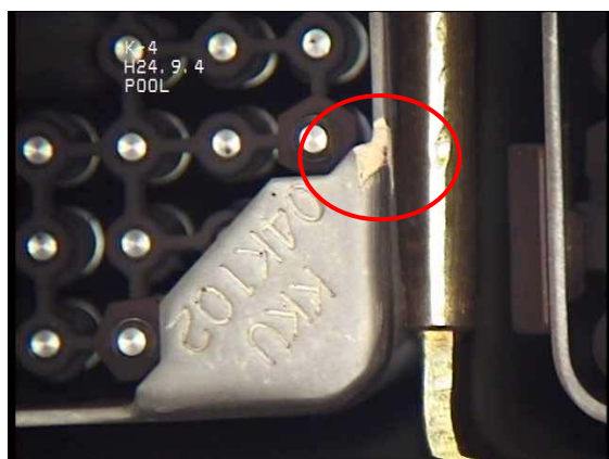
図 2 4号機の使用済燃料プールで確認されたクリップ接合部の状況
