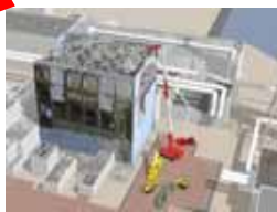
原子炉建屋上部のガレキ撤去
