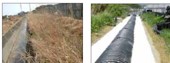
図2：排水路の暗渠化の様子
