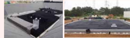
地下貯水槽設置状況
