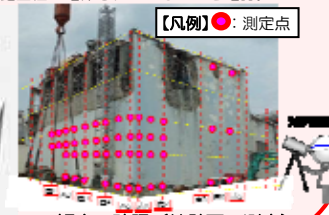
傾きの確認(外壁面の測定)
