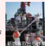
新燃料取出し作業
