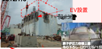
原子炉建屋上部のガレキ撤去
