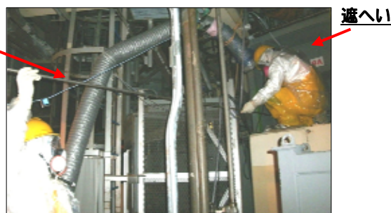
図1：2号機格納容器温度計設置の様子
