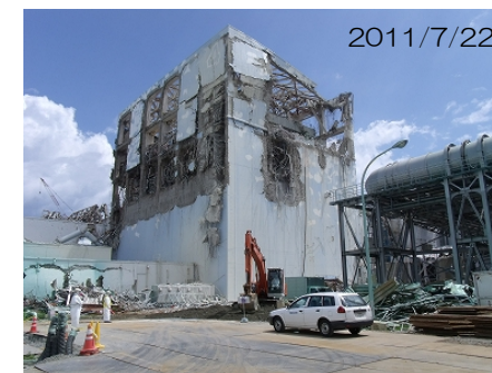
図5. 4号機原子炉建屋上部瓦礫撤去の状況
